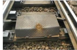
Fig. 3 Dispozitivul ajutător de manevrare cu arc (DAM) aferent macazului nr.3
