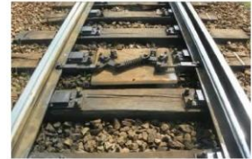
Fig. 4 Dispozitivul ajutător de manevrare cu arc (DAM) aferent macazului nr.14
