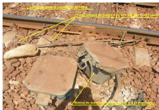
Fig. 3 Bobina de joantă I XC SAT 282 + 232 deplasată cu funiile de oțel rupte
