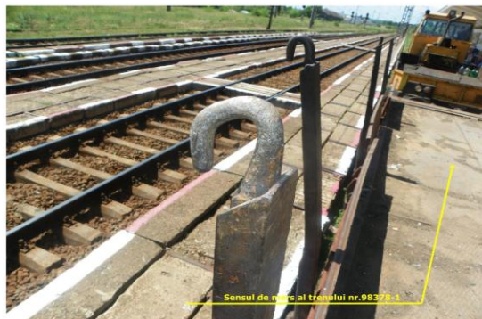
Fig. 7 Țepușa a-4-a pe partea stângă sens de mers cu urme de lovituri
