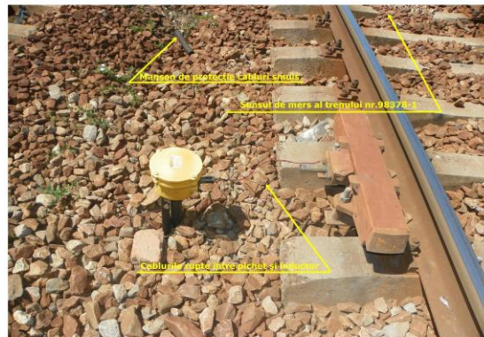
Fig. 4 Manșoanele de protecție a cablurilor smulse și cablurile rupte între picheti și inductorii
